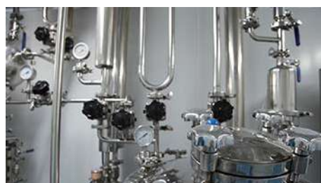
在线清洗与在线灭菌系统（CIP+SIP）
